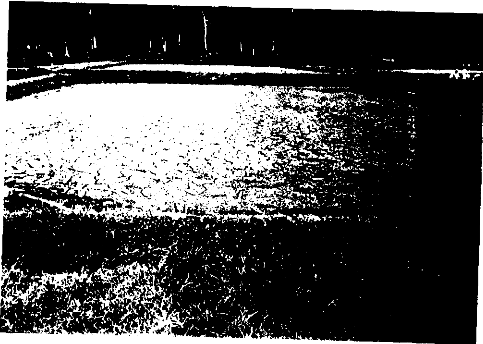
Gambar 1. Pengeringan tanah dasar kolam
