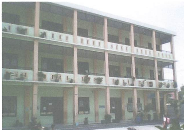
Foto 3. Gedung sisi timur SDN Sidotopo Wetan I Surabaya
