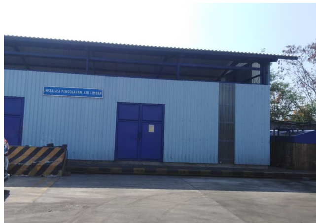
Gambar 4.5 Area WWTP PT Jasa Kepelabuhanan Sumber : Data Pribadi, 2023
