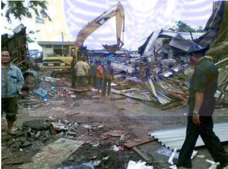
Gambar III.26. Foto pihak PT.KAI dan PT.PELINDO III menggunakan alat eskavator untuk merubuhkan rumah warga. Sumber: Tribun News.com
