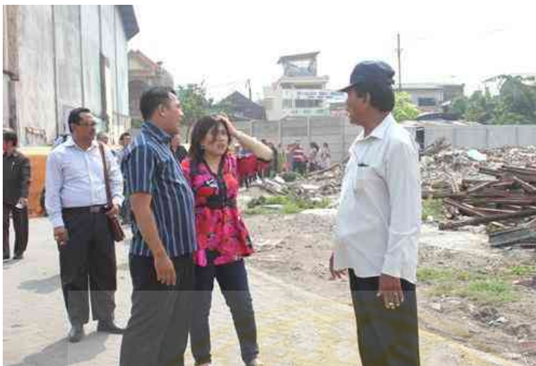
Gambar III.22. Sidak Komisi A DPRD Surabaya melihat kondisi Kalimas Baru. Sumber: beritajatim.com
