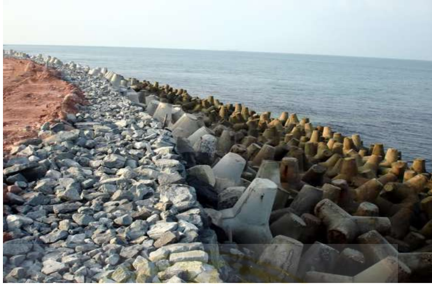
Gambar 2.3: Pemasangan Tetrapod di depan tembok laut Pulau Nipa 56
