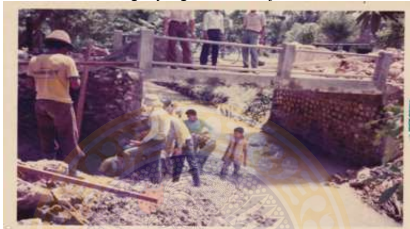
Gambar 12 Gotong royong merenovasi jembatan
