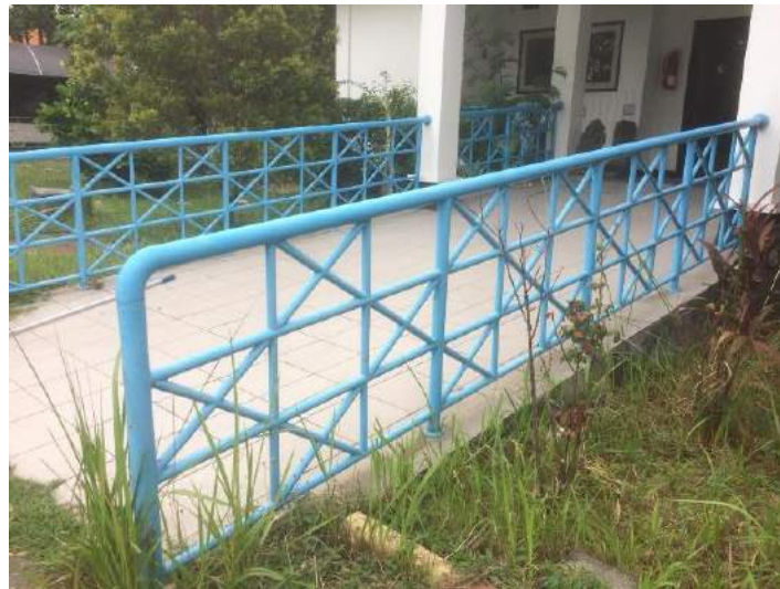
Gambar 3.2 Ramp dan HandRail Gedung Tuna Netra Museum Negeri Mpu Tantular
