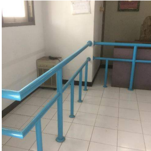
Gambar 3.4 Handrail Dalam Gedung Tuna Netra Museum Negeri Mpu Tantular
