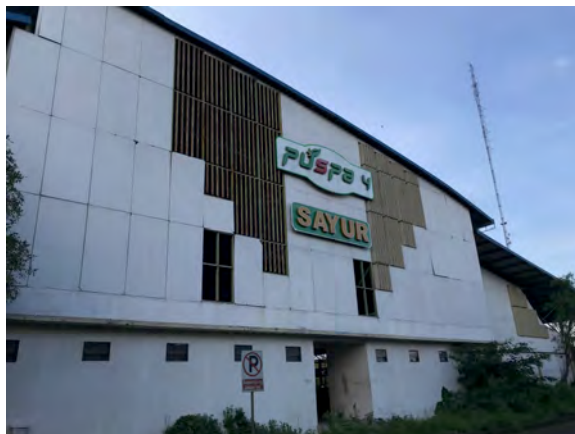
Gambar 2.5 Gedung Sayur Puspa Agro. (sumber: dokumentasi pribadi)
